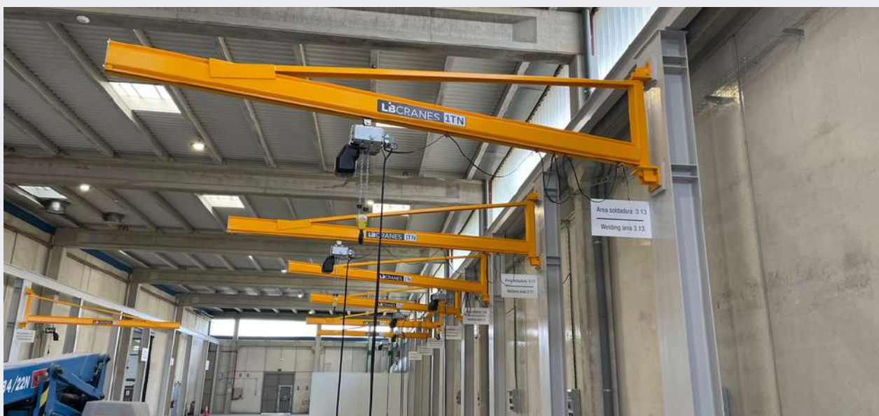
Projet de 11 grues murales à flèche de 1 tonne.
