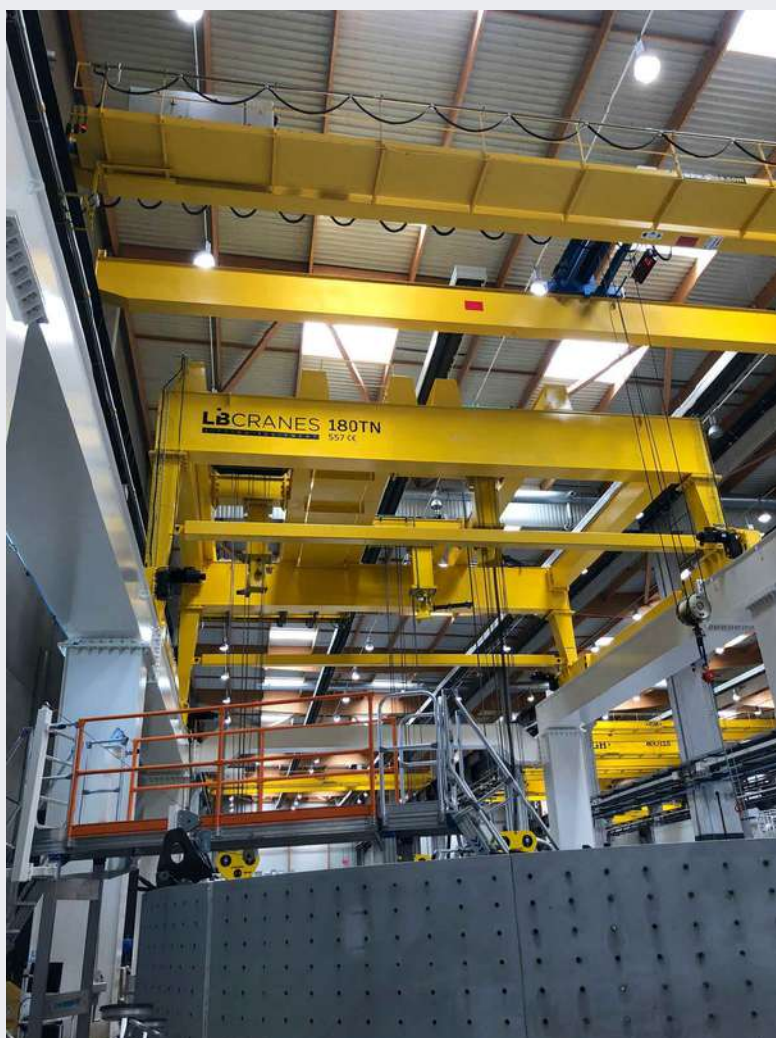
Grue de traitement de 180 tonnes.
